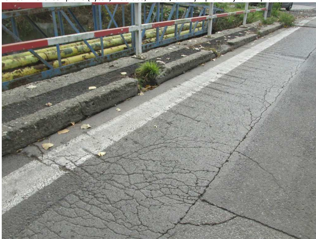
12) Pohled k vozovce vpravo (výtok) – obruba, římsa / trhliny v pravém jízdním pruhu
